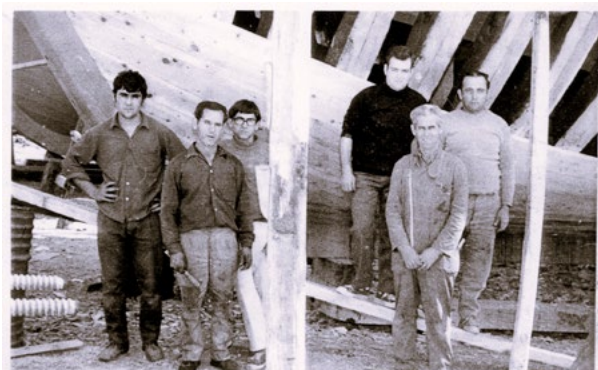
Trabajadores del astillero en el nuevo emplazamiento junto al varadero. Años 70. Archivo Andrés Aguilera.
