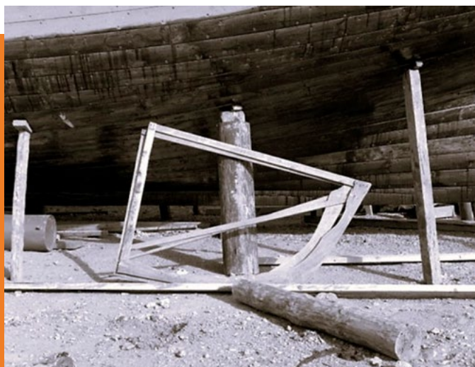
Foto 9. Plantilla para fijar el tanque de combustible en el interior del casco de un barco en el muelle de ribera. Museo digital de Bohuslän. Autor: Olof Hasslöf. 12 de noviembre de 1959.
