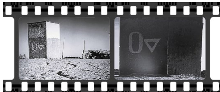
El transformador que da energía a las grúas que trabajan en la punta del espigón, convertido en la Zona Cero . Los signos pintados para identificar el lugar de la detonación nuclear que indican advertencia y peligro.
