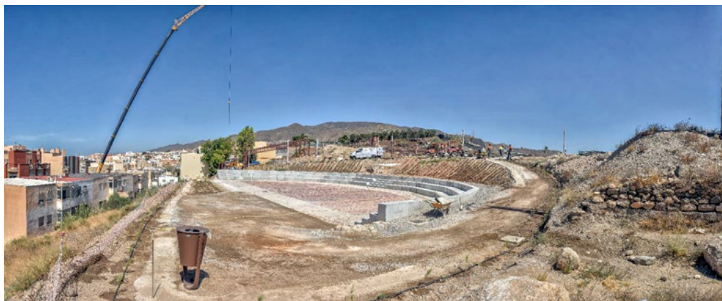
Nuevo teatro al aire libre construido dentro de los nuevos equipamientos del Cerro de Montecristo. Foto Andrés Aguilera.
