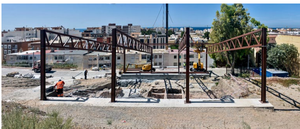
Trabajos de acondicionamiento y accesibilidad del nuevo parque arqueológico de Montecristo. Foto Andrés Aguilera.
